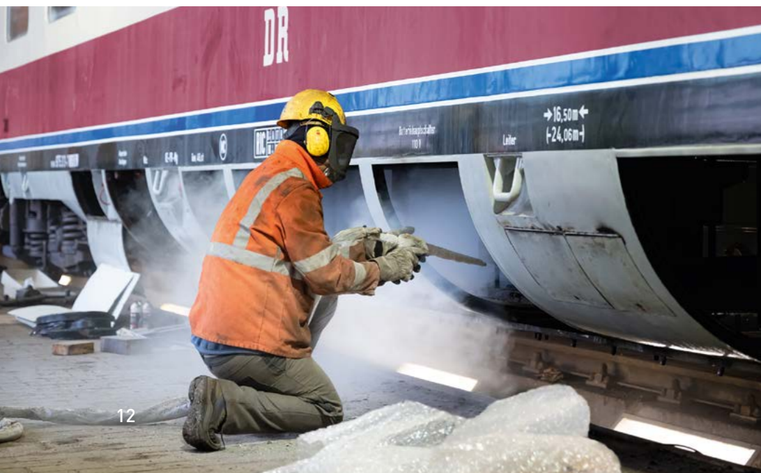
Reinigung der Batteriekästen
